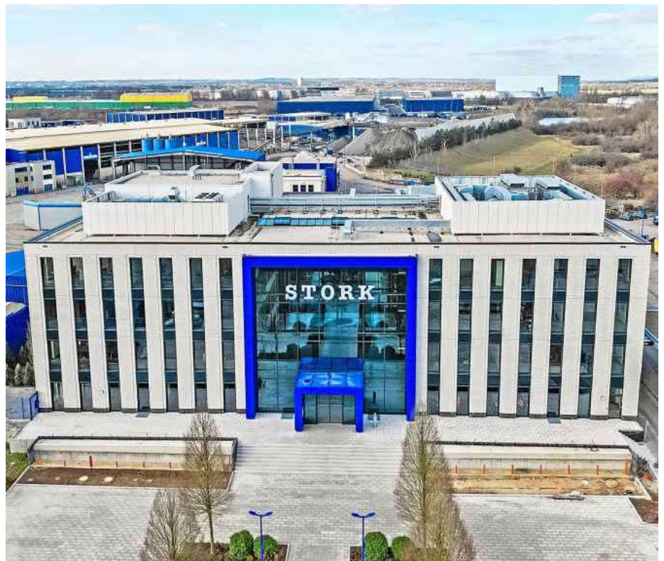
Am Hauptsitz der Stork-Gruppe in Magdeburg werden acht Müllverbrennungsanlagen aufbereitet. Stork
